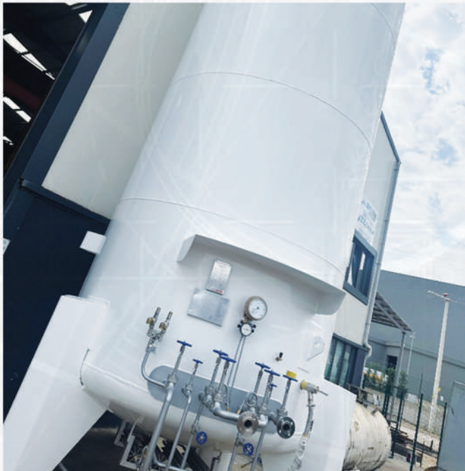
Alt bombeden çıkışlı vana grubu sifon dizaynı
